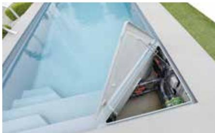
Die Technik kann direkt im Technischacht beim Becken installiert werden.
